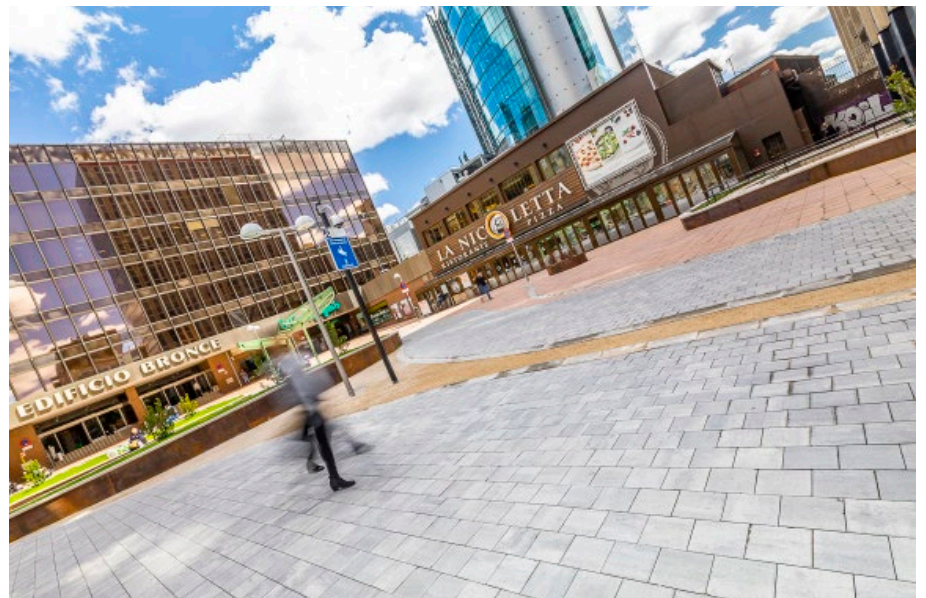
Pavimentación del entorno de la Plaza de Azca en Madrid con tratamiento RENOVAIR
