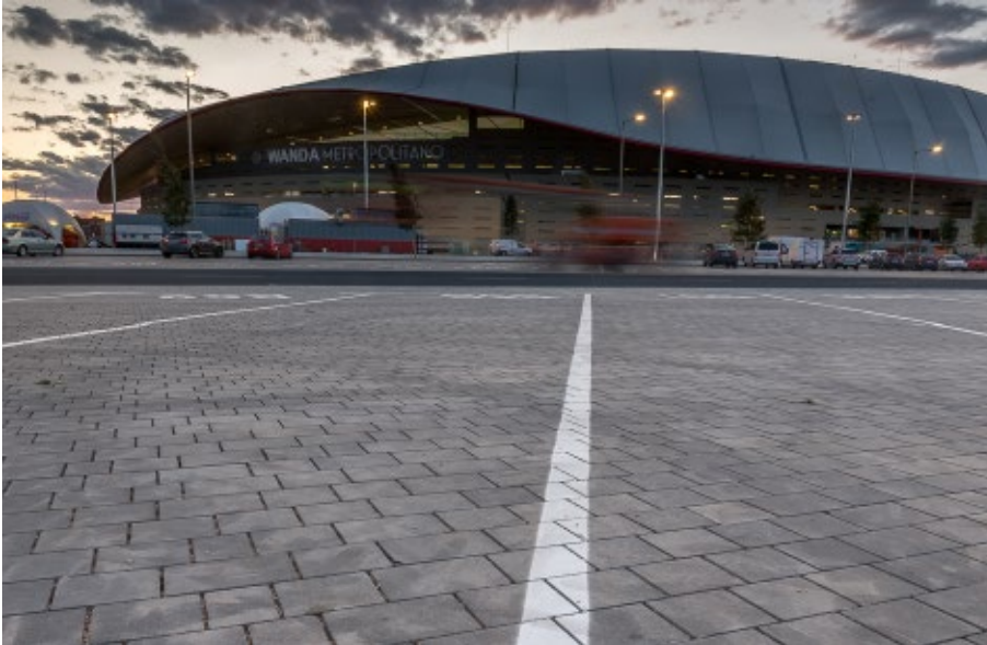
Adoquinado multiformato con sistema drenante ECOAQUA y acabado RAW, para la zona de parking de autobuses del estadio Wanda Metropolitano de Madrid.
